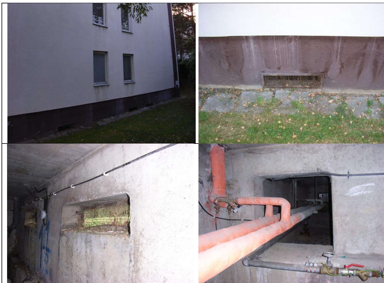
Obrázek 173 – fotografie příkladu zvýšené podlahy pod panelovým domem – tzv. „montážní podlaží“. Fotoarchiv DEKPROJEKT s.r.o.
